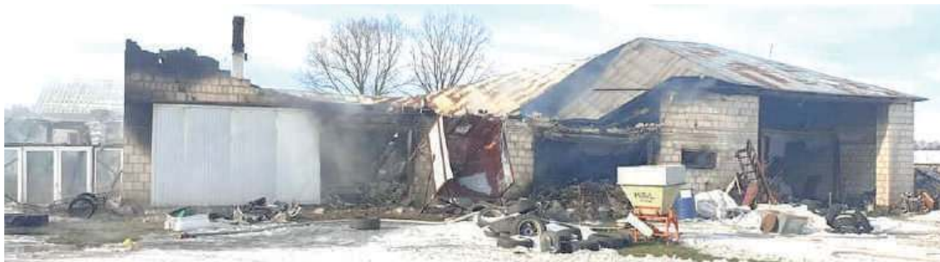
Świder. W przypadku tego pożaru przyczyną było zwarcie instalacji elektrycznej w zaparkowanym w garażu samochodzie
