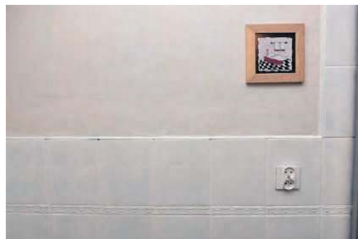
Płytki łazienkowe przemalowane specjalistyczną farbą.
