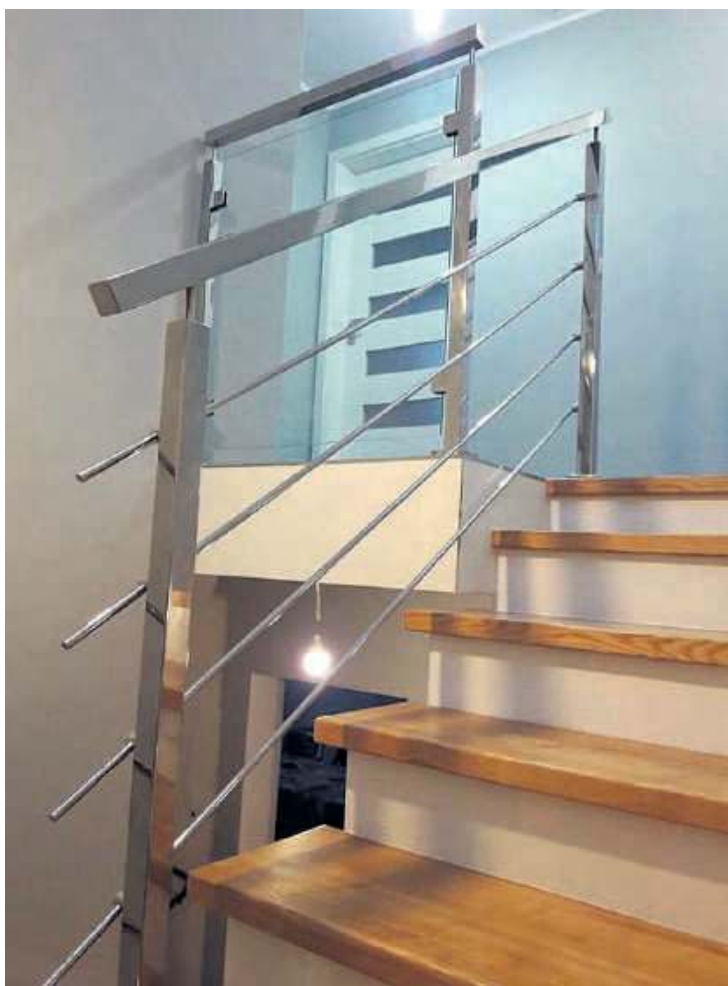
Projekt z zastosowaniem słupków kwadratowych, minimalistyczny.
