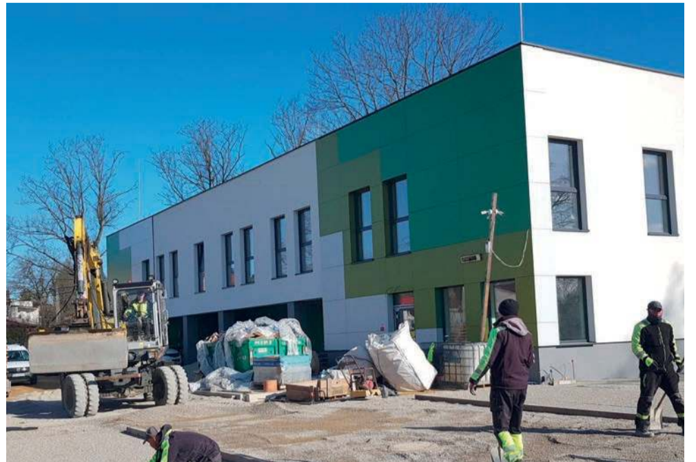
Trwają roboty na placu obok nowego budynku
