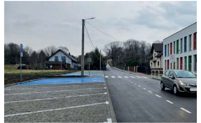
Wyremontowana ul. Dworska w Chrzanowie
