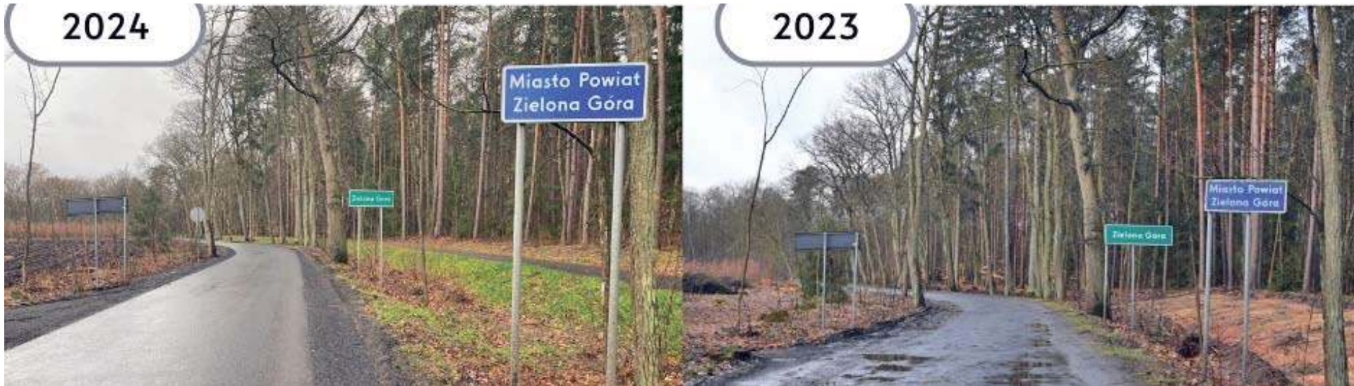
Droga w kierunku Zielonej Góry została wyremontowana (ilustracja: powiat nowosolski)
