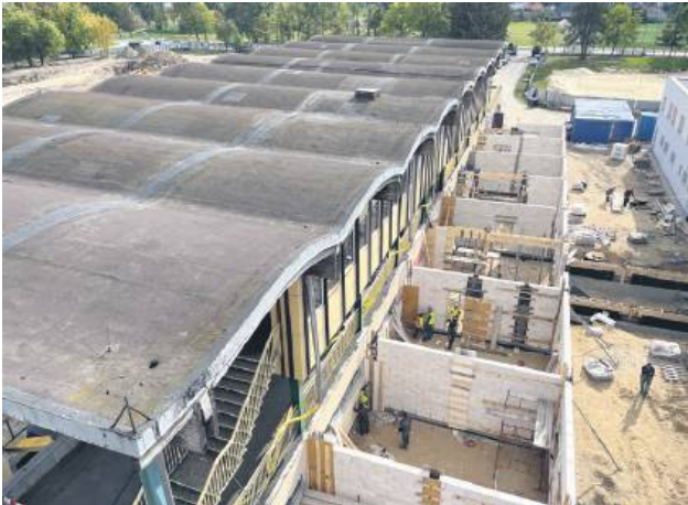
Pierwszy etap przebudowy zamojskiego stadionu lekkoatletyczno-piłkarskiego przy ul. Królowej Jadwigi zakończy się w czerwcu.
