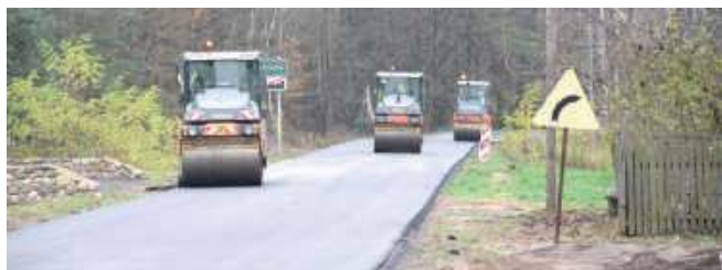
Drogowcy położyli drugą warstwę asfaltu, ale inwestycja ma być gotowa w całości dopiero latem przyszłego roku
