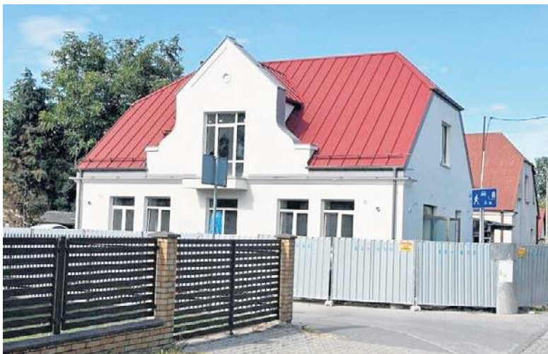
„Straszny dworek” przechodzi gruntowną modernizację.
