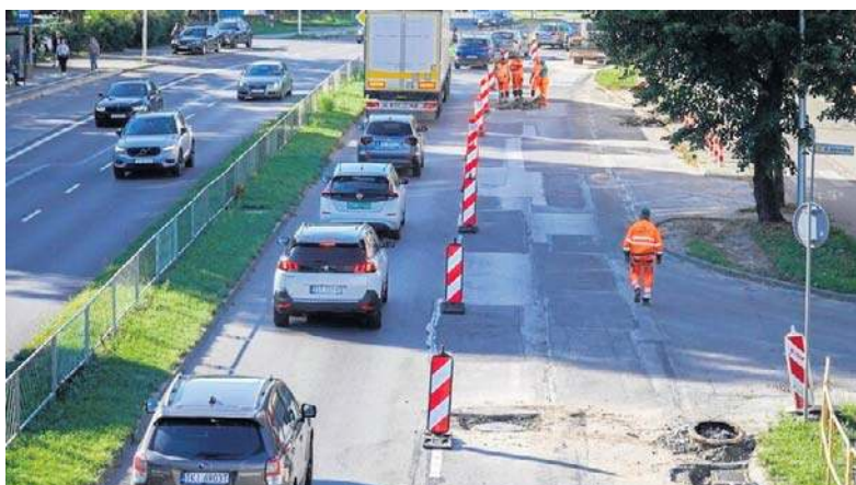
Rozpoczął się remont ulicy Źródłowej w Kielcach. Prace mają zakończyć się jeszcze w tym tygodniu
