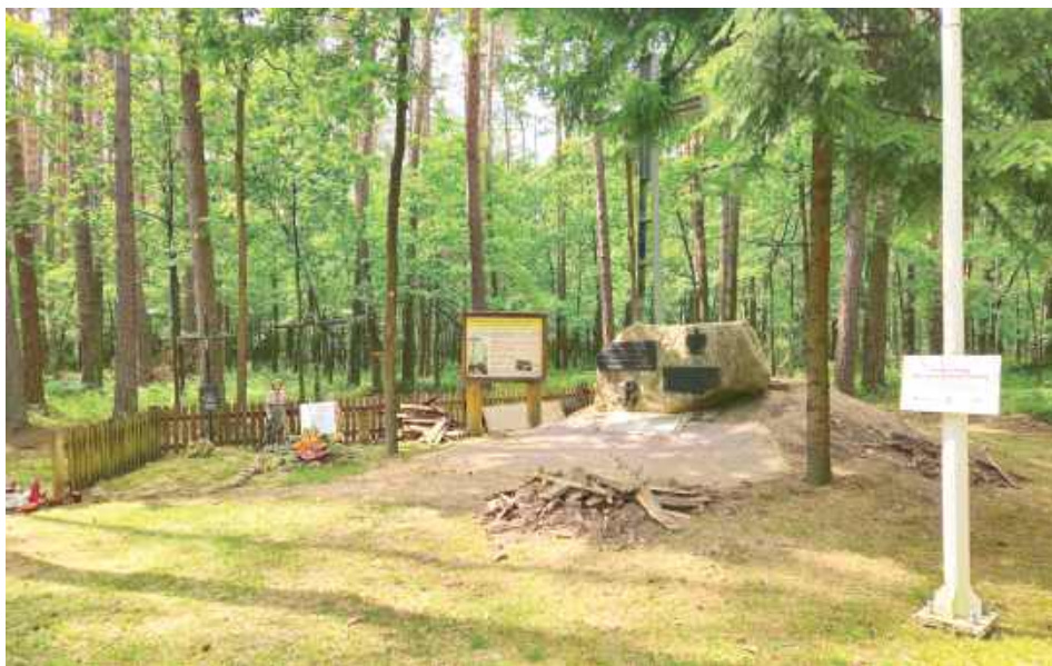
Prace przy modernizacji miejsca pamięci Uroczysko Baran w Kąkolewnicy to czwarte miejsce na terenie gminy, które jest modernizowane z Rządowego Programu Odbudowy Zabytków
