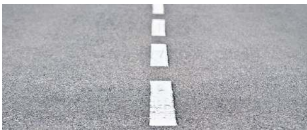
Wykonanie jednego metra oznakowania to koszt niemal 100 zł.
