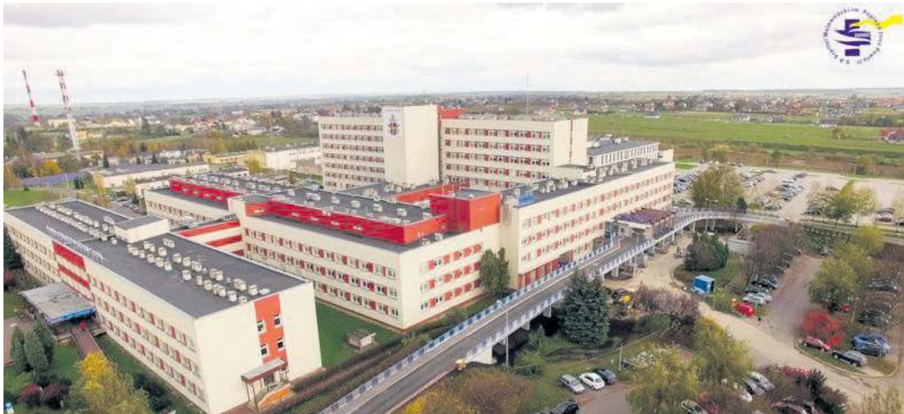
W ramach projektu w placówce zostanie przeprowadzona modernizacja sieci komputerowej i infrastruktury serwerowej.
