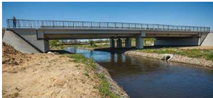
Nowy most na Płonce
