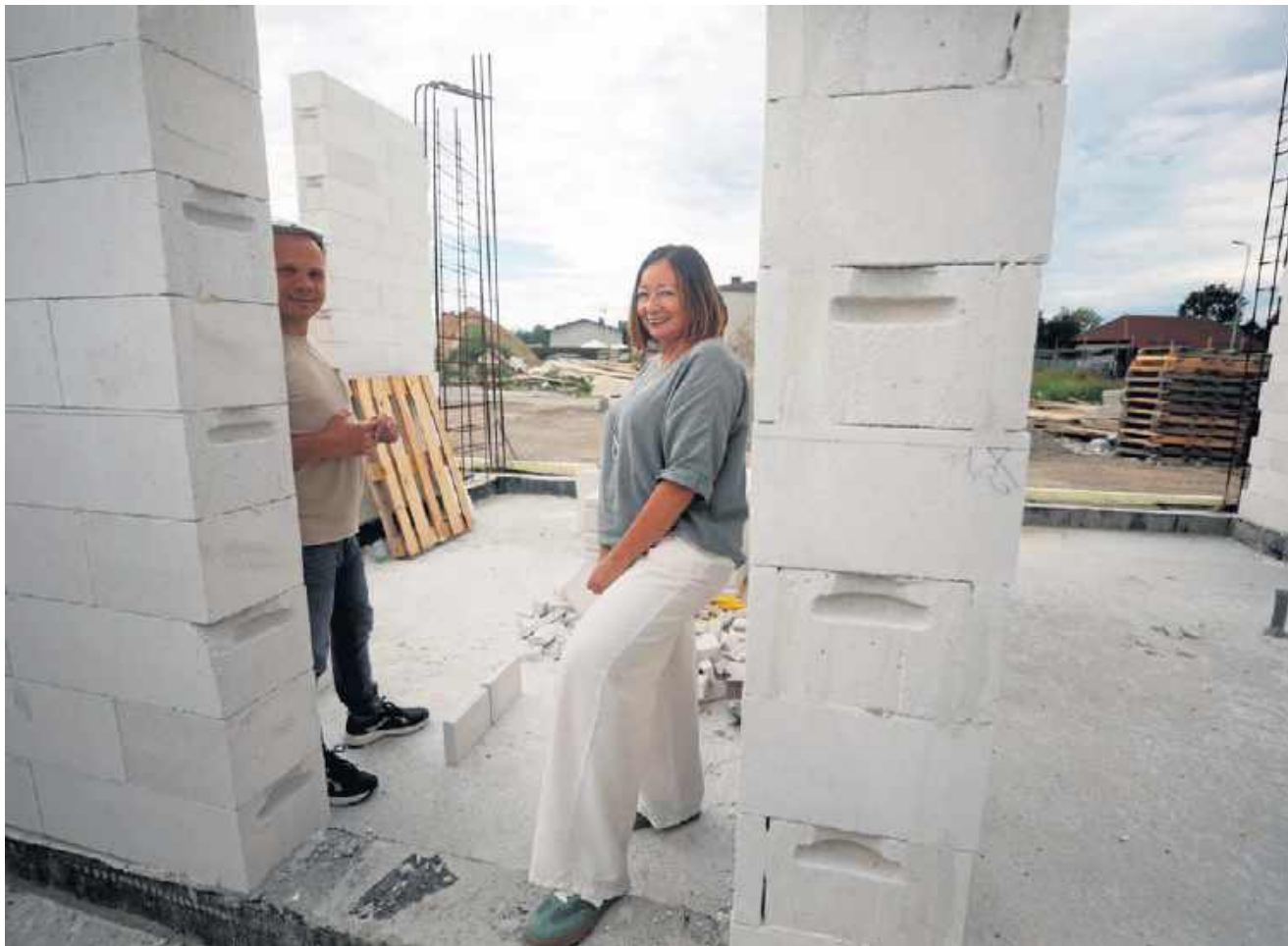
Prace budowlane rozpoczęły się na przełomie listopada i grudnia. Trwa wznoszenie ścian
