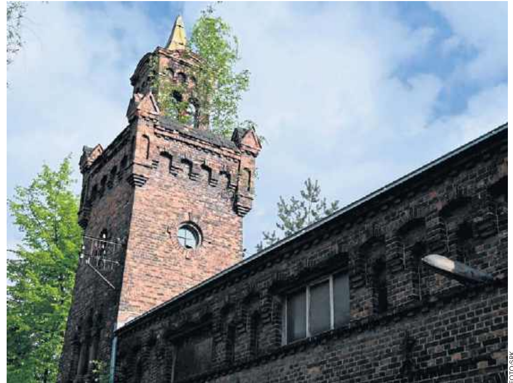
W budynkach nadszymbia i maszynowni powstaną mieszkania wspomagane
