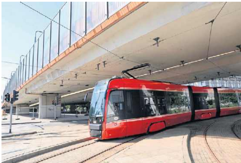
Tramwaje i autobusy ponownie mogą jeździć pod estakadą
