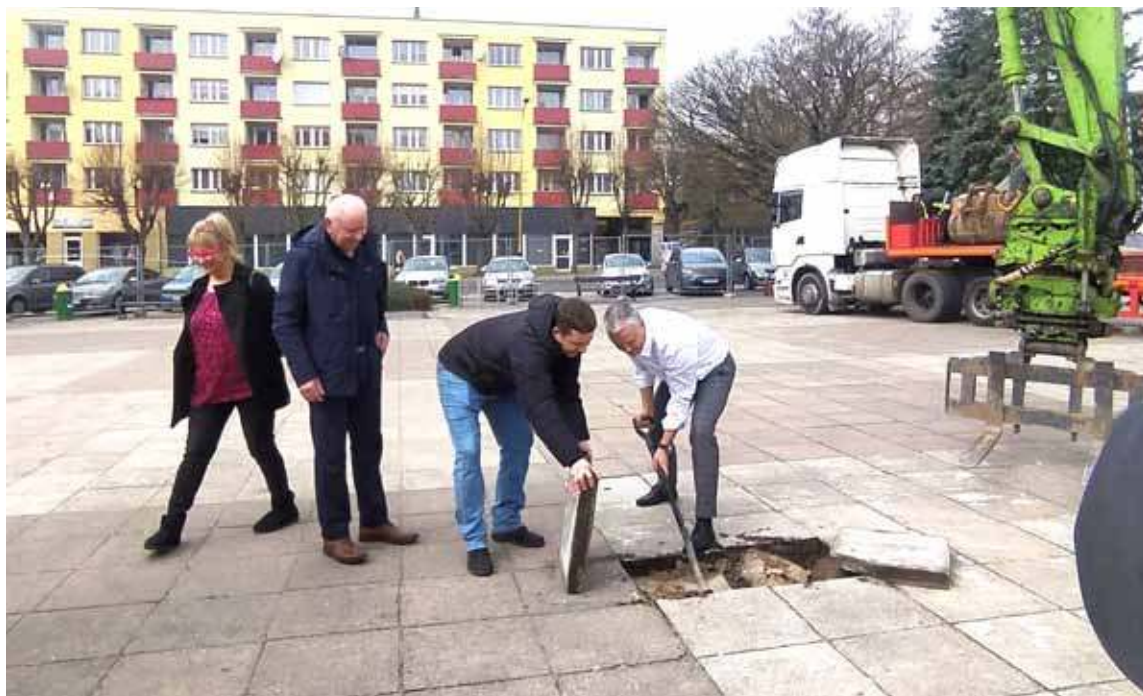
Prace rozpoczęto od demontażu wysłużonych płyt na placu
