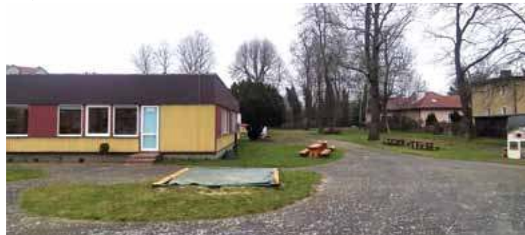
Dodatkowe pomieszczenie zostanie dobudowane tuż przy istniejącym obiekcie przedszkola
