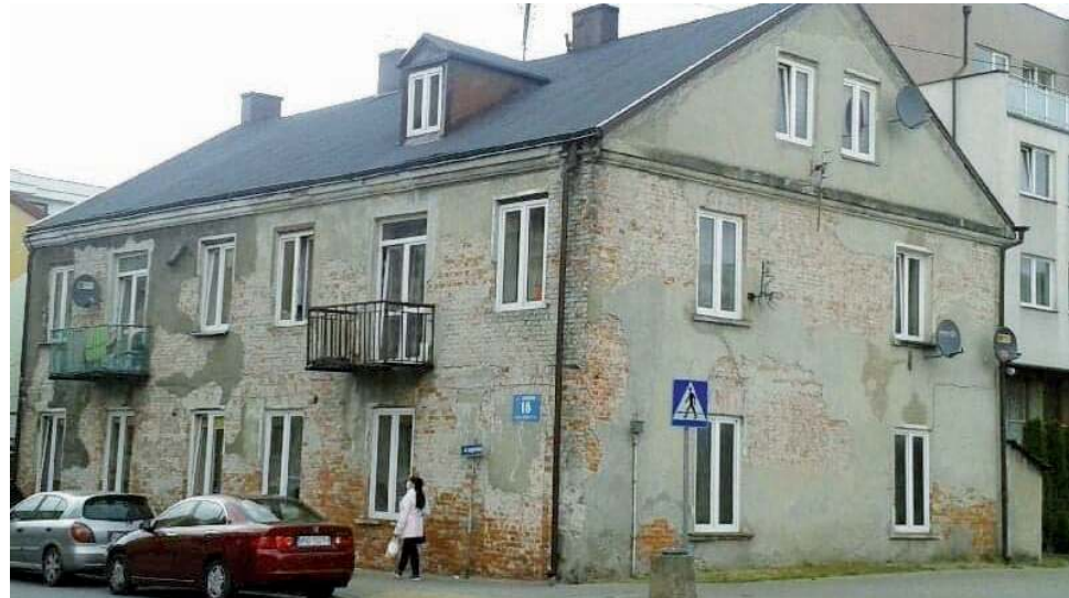
Budynek do remontu przy ul. Legionów 18
