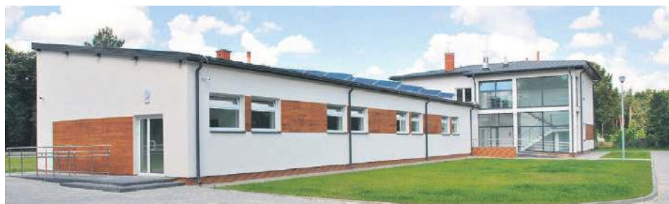
Centrum Geoturystyczne po metamorfozie. Fot. UG Zamość
