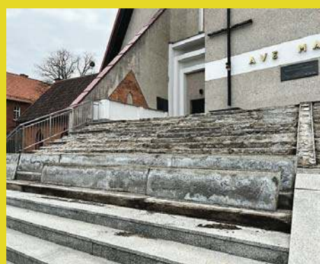
Burzą schody do kościoła 4
