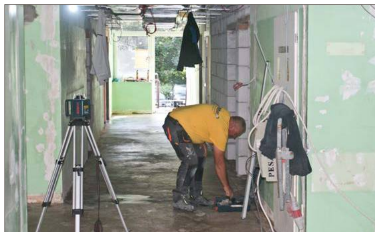
Najwięcej do zrobienia zostało na SOR. Tu do końca remontu daleko.
