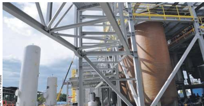
Budowa instalacji do produkcji zielonego glikolu przebiega zgodnie z planem. To samo dotyczy wytwórni wodoru na potrzeby glikolu, powstającej w ramach tej samej inwestycji
