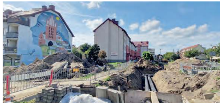
Na czas prac modernizacyjnych konieczne było wyłączenie sieci (fot. Gm. Goleniów)
