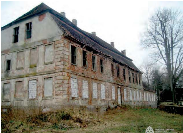
Pałac w Łoźnicy (fot. zabytek.pl)
