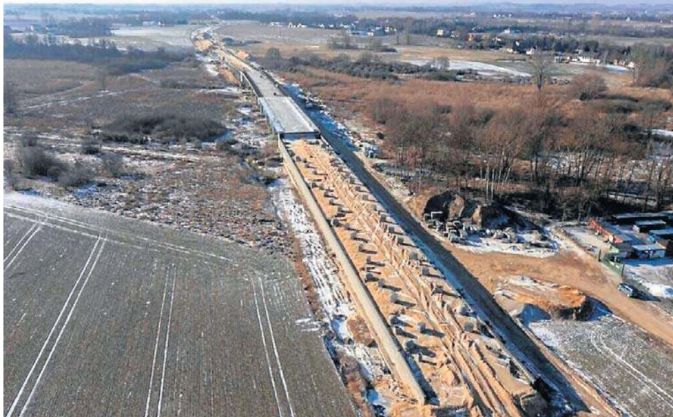
Najbardziej zaawansowane prace są przy budowie obwodnicy Mogilna
