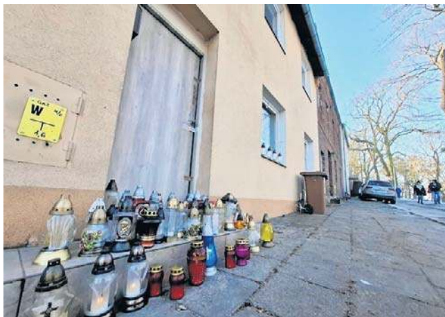
W połowie stycznia w domu przy Starych Plantach tlenkiem węgla śmiertelnie zatrulią się matka i jej troje dzieci
