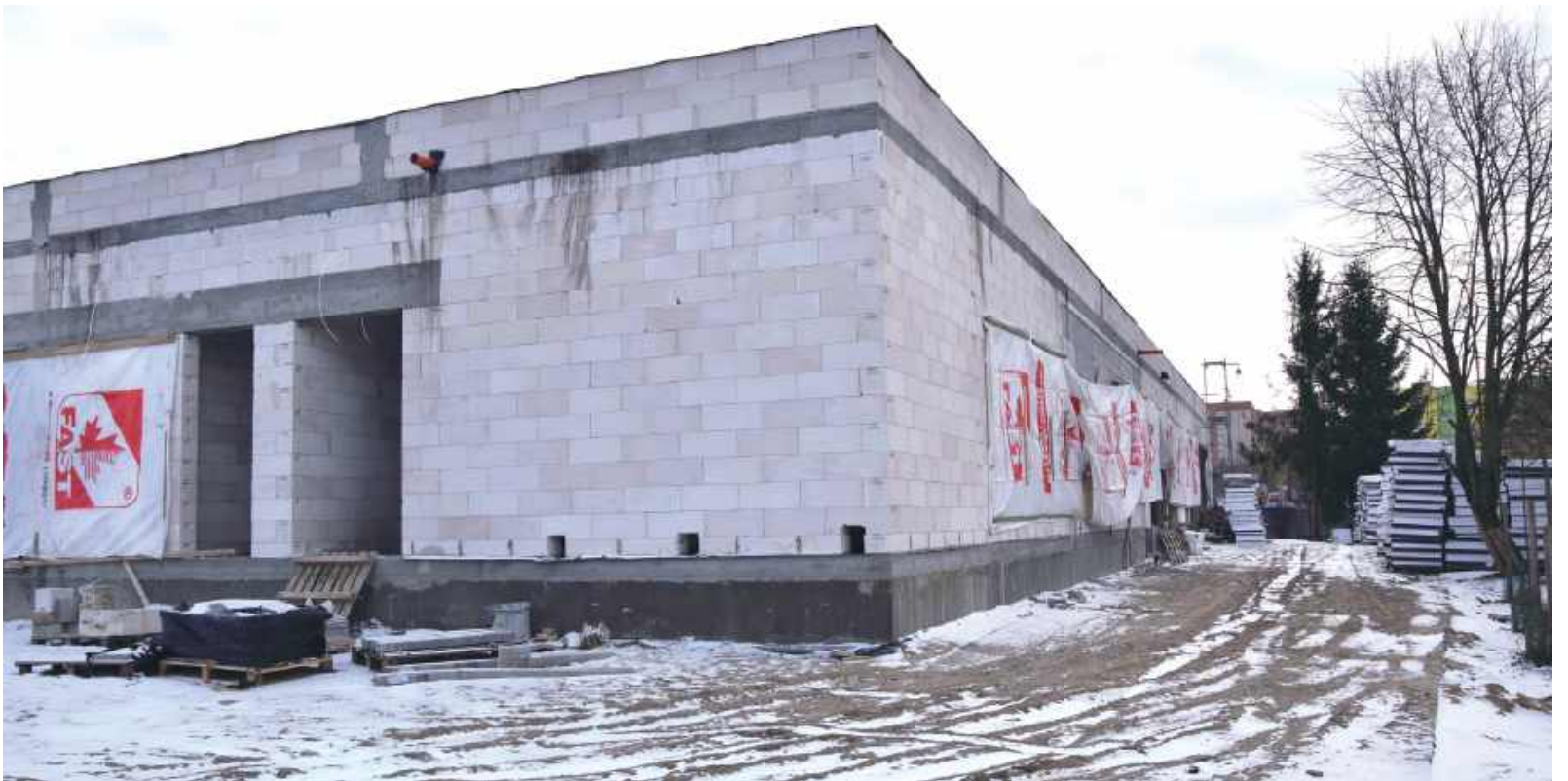
Największą inwestycją będzie kontynuacja budowy przedszkola przy ulicy Jaśminowej
