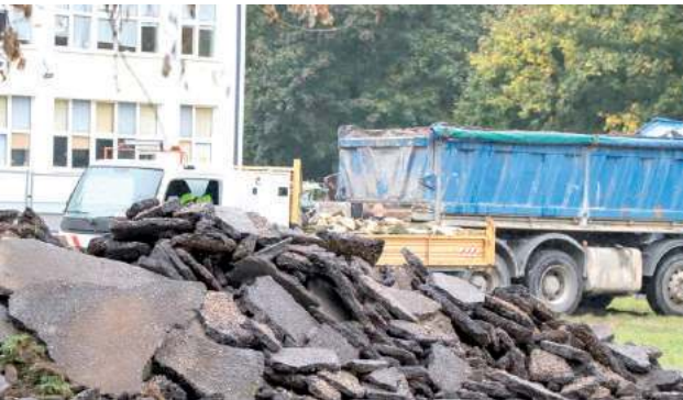
Wykonawca budowy boisk przy SP 3 zaczął od rozebrania zniszczonej nawierzchni starego obiektu. Prace ruszyły jeszcze w październiku
