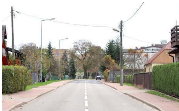
Remont przebiega odcinek o długości ok. 410 metrów od wyniesionego przejścia dla pieszych przy Tawernie nad Wisłą do ulicy Wiślanej. Ten odcinek dotąd nie był modernizowany
