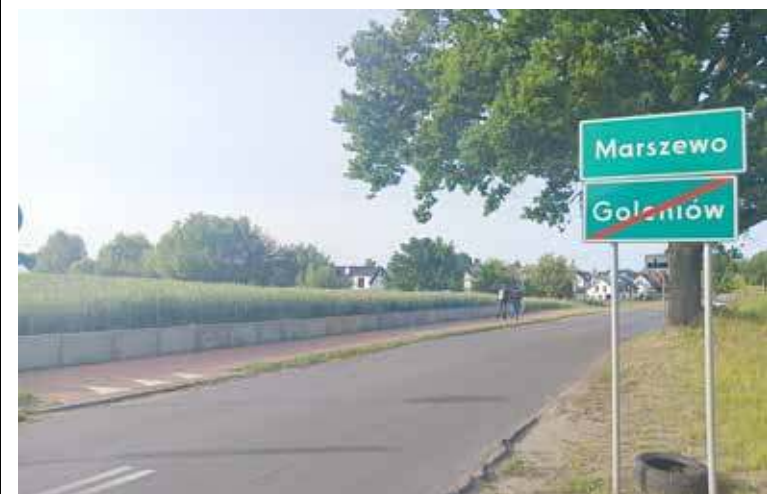
Droga w Marszewie jest rozbudowywana
