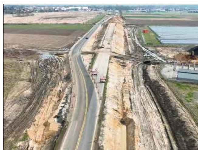
Zmiany mają związek z trwającą rozbudową drogi krajowej nr 45 na odcinku o długości 6,6 km.
