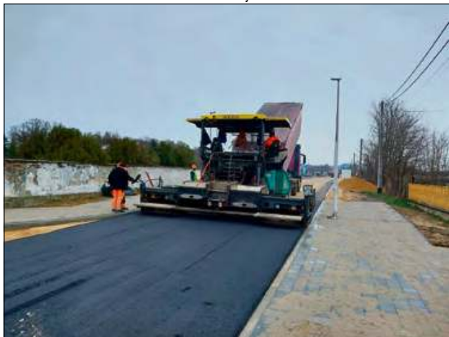
Postęp prac na drodze powiatowej 1808 ulica Góra Św. Anny w Zdzieszowicach.
