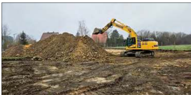
Koparki poszły w ruch.
