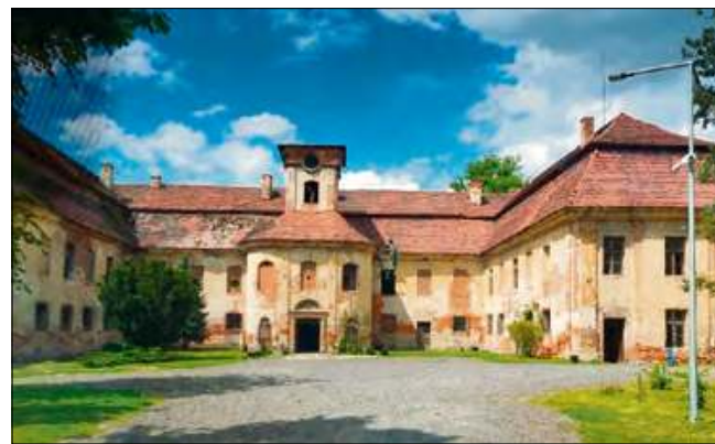
W tle remontu pałacu w Rozkochowie kryje się nadzieja na odrodzenie jego roli jako miejsce spotkań, nauki i inspiracji dla przyszłych pokoleń.
