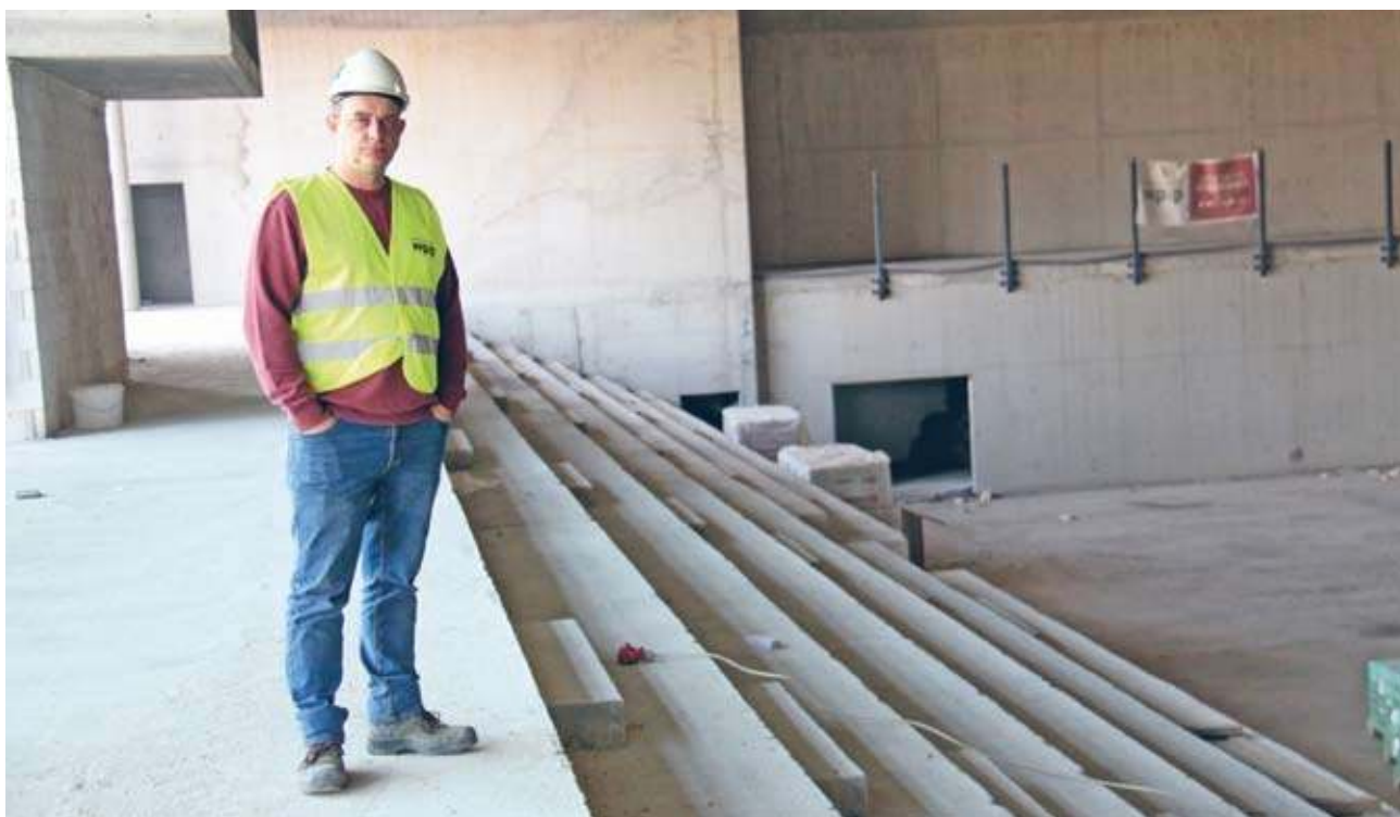
Łukasz Tkaczyk, kierownik budowy z firmy W.P.I.P.
