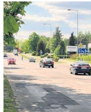
Na ul. Jagiełły znowu prowadzono prace
