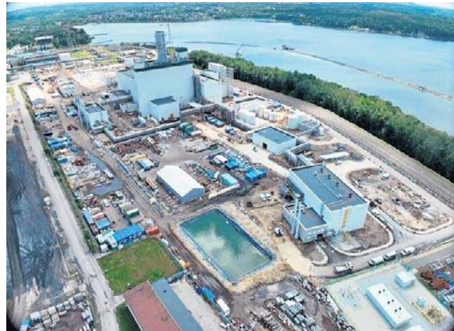
W Rybniku budują najnowocześniejszą elektrownię w Europie. Dostarczy prąd do milionów domów
