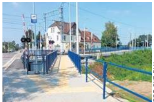
Na stacji Olza powstały nowe dojścia do peronów
