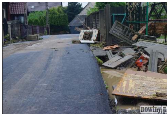
Ulica Potocka po ustąpieniu wody
