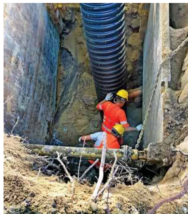
Budowa sieci kanalizacji sanitarnej
