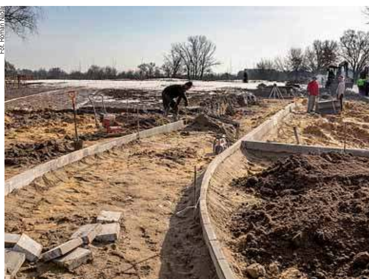
W sąsiedztwie parku wykonywane są miejsca parkingowe
