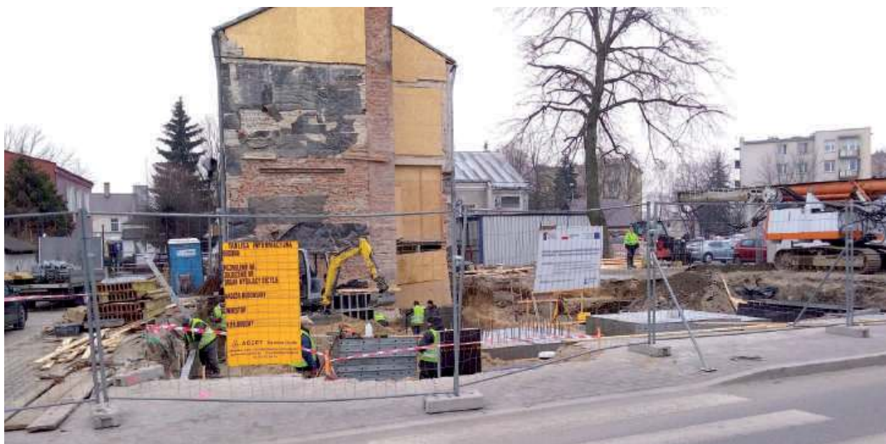
W szybkim tempie radzyńska firma wznosi nowy budynek na miejscu przedwojennej kamienicy
