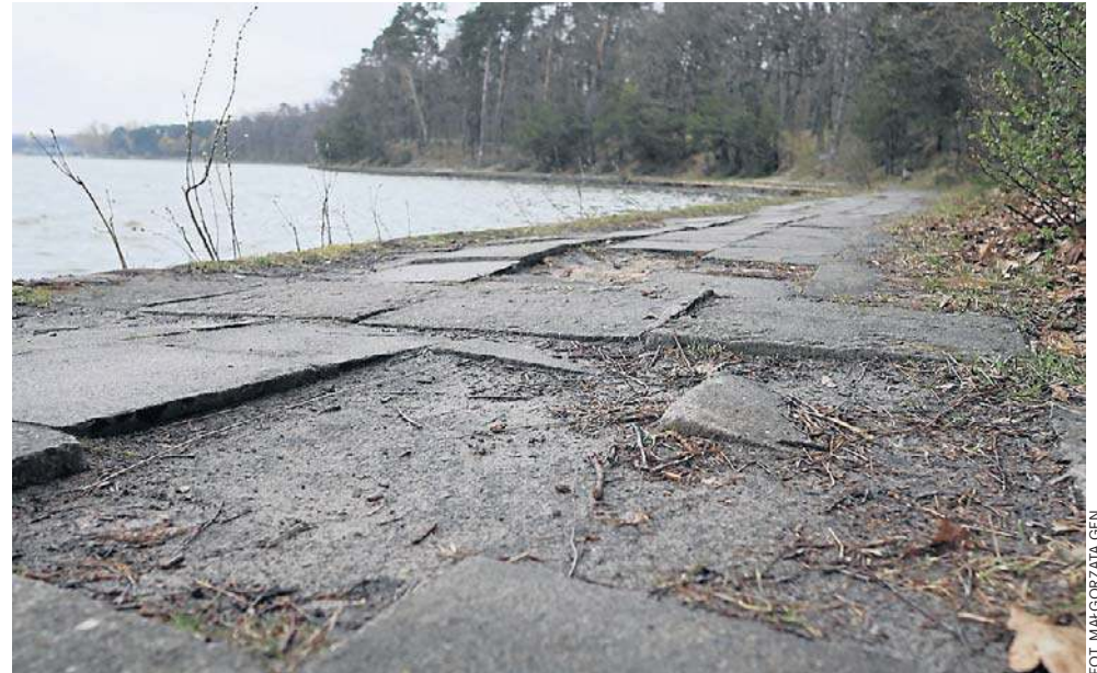
Na ponad kilometrowym odcinku, od strony ul. Osmolickiej ma powstać wygodny chodnik i opaska. Prace powinny zakończyć się jesienią
