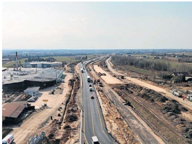
Odcinek między Lublinem (węzeł Rudnik) a Lubartowem (węzeł Lubartów Północ) ma 23 km długości
