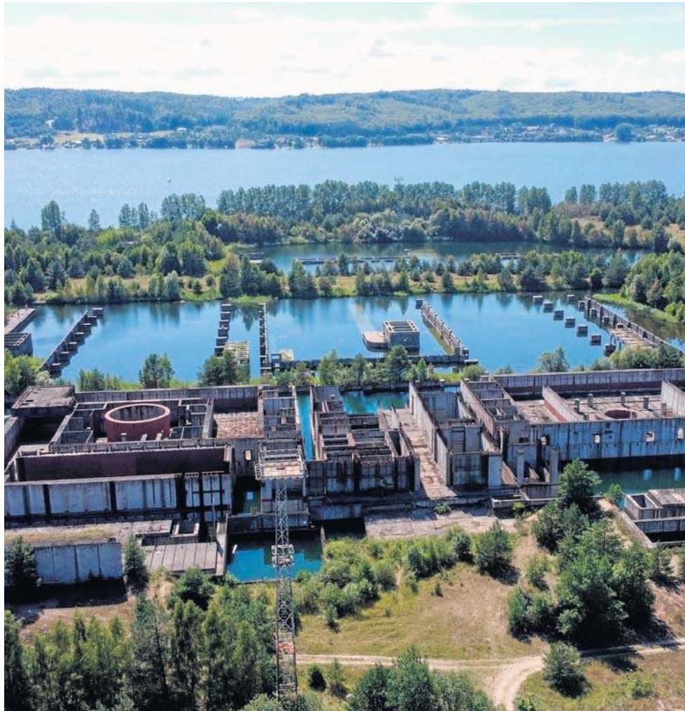
17 grudnia 1990 r. rząd Tadeusza Mazowieckiego podjął uchwałę o postawieniu inwestycji „Elektrownia Jądrowa Żarnowiec w budowie” w stan likwidacji
