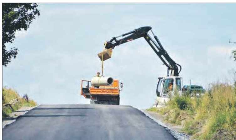
Kolejną skanalizowaną miejscowością w gminie Głogówek będzie Kierpień
