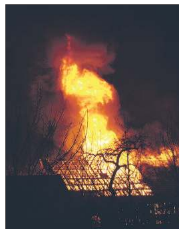
Ogień uszkodził dach domu.
