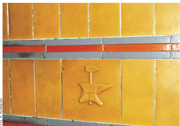
Fragment wewnętrznej ściany sieni ZSZ
