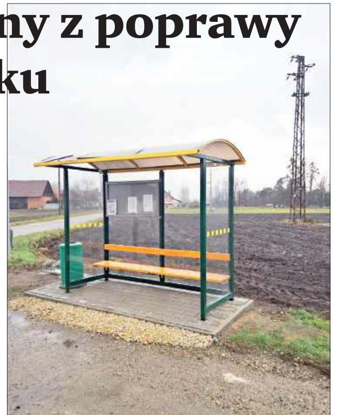
■ Wiatę umiejscowiono przy skrzyżowaniu dróg gminnych ulic Leśnej i Okrężnej (mad)
