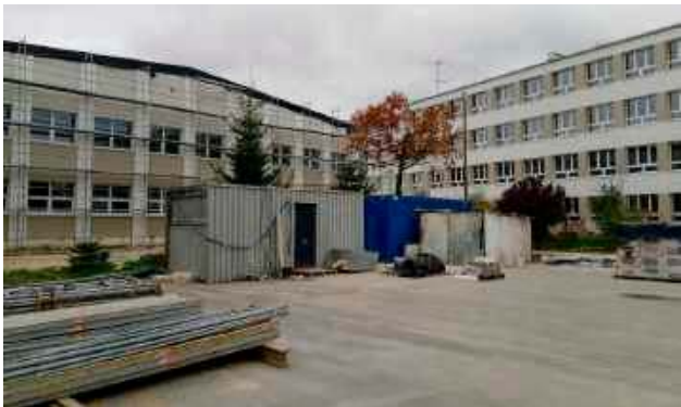
„Kolejówka” dzięki termomodernizacji zyskała również gustowną elewację
