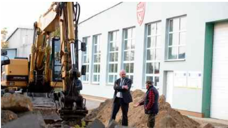
Przebudowa kanalizacji jest na ukończeniu
