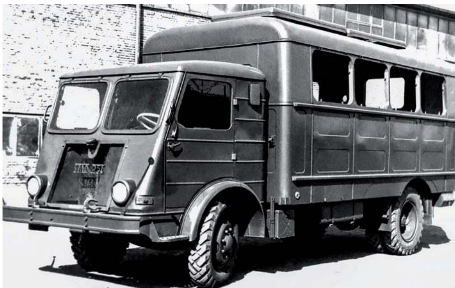
▲ Prototyp nadwozia stalowego N 116 na podwoziu Star 25L.
