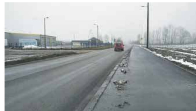
Oznakowanie poziome na ścieżce rowerowej przy ul. Knosały już jest, na jezdni wciąż go brakuje
