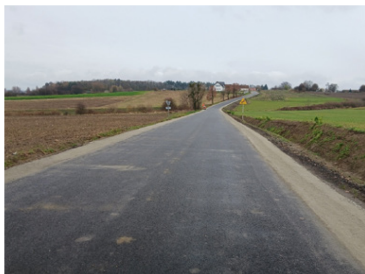
Modernizacja drogi powiatowej nr 1284D Wołów- Gródek.
