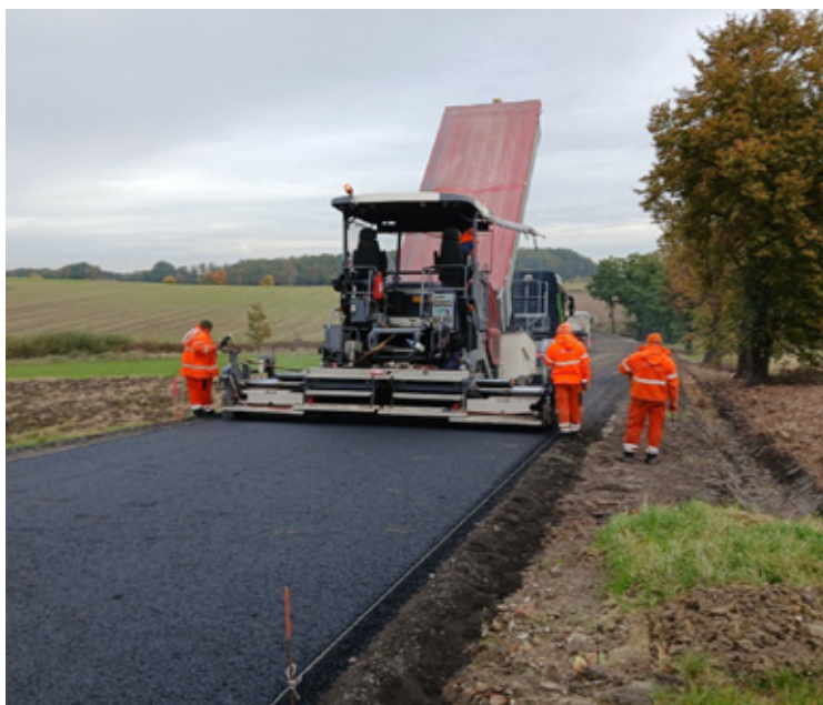
Modernizacja drogi powiatowej nr 1284D Wołów- Gródek.
