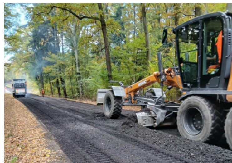
Modernizacja drogi powiatowej nr 1284D Wołów-Gródek.
