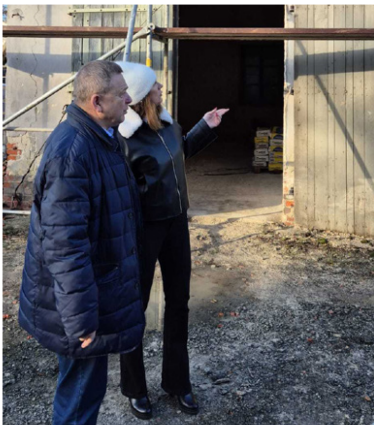
Modernizacja budynku na potrzeby utworzenia bazy magazynowej Wołów ul. Kościuszki.
