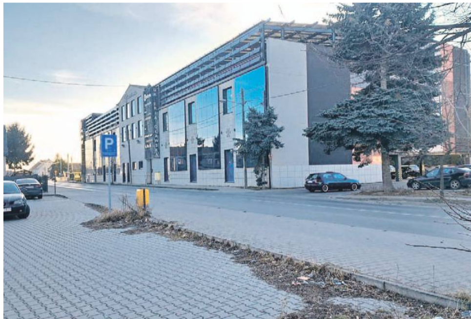
Tu będzie nowe przejście dla pieszych
