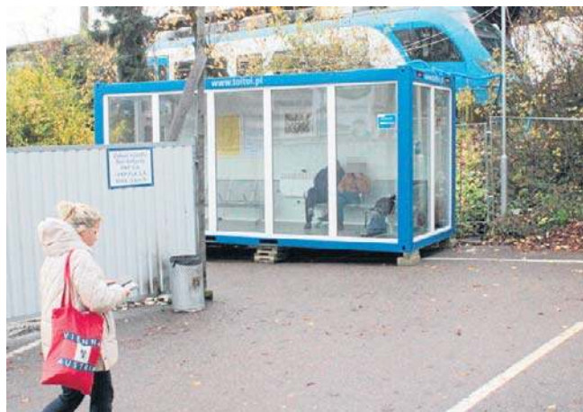
Stary dworzec PKP został wyburzony. Od niedawna została udostępniona tymczasowa poczekalnia
