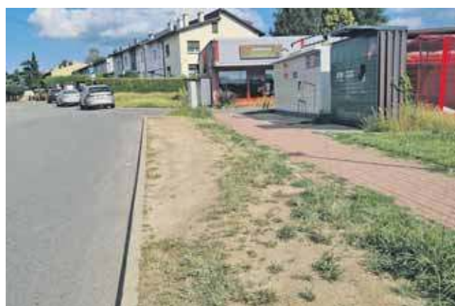
Według radnego kierowcy, chcąc skrócić czas dostaw, regularnie wjeżdżają na chodnik oraz przyległy teren zielony. Efektem są uszkodzenia nawierzchni, zapadająca się kostka brukowa i koleiny
