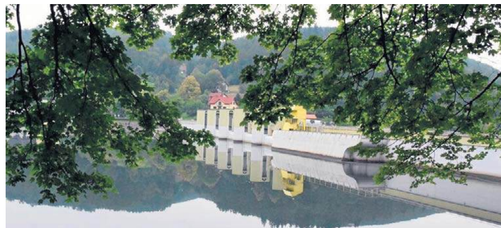
W tym roku na remonty i modernizację zapory Wody Polskie przeznaczyły 4,5 mln zł
