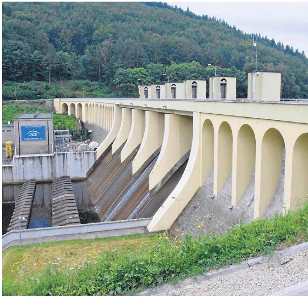
Zapora Porąbka to betonowa konstrukcja o długości 260 m i wysokości 38 m
