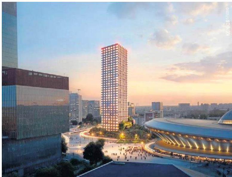
34-kondygnacyjny wieżowiec zaplanowano przy Chorzowskiej 1
