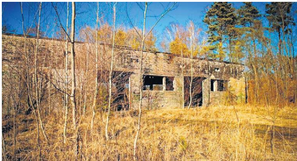
Teren oraz obiekty po 11. Dywizjonie Rakietowym Obrony w Kuźni Raciborskiej
