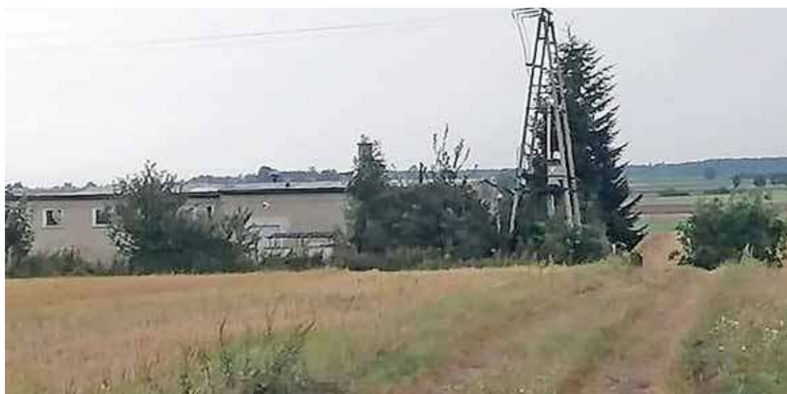
Ujęcie wody w Kałęczynie (gm. Gołymín Ośrodek)
