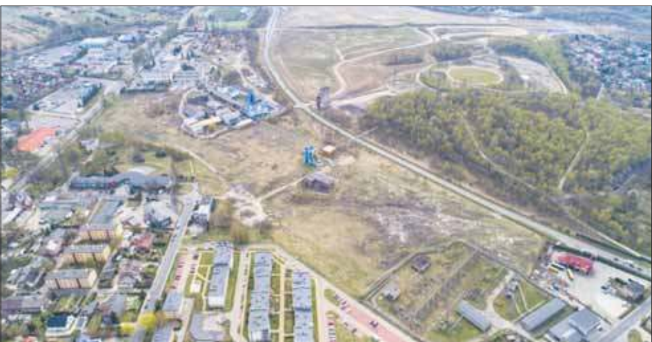
Farma powstanie na terenach po Elektrowni Jaworzno I
