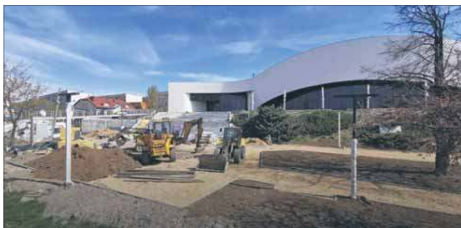
Remont elewacji ma się zakończyć do końca kwietnia
