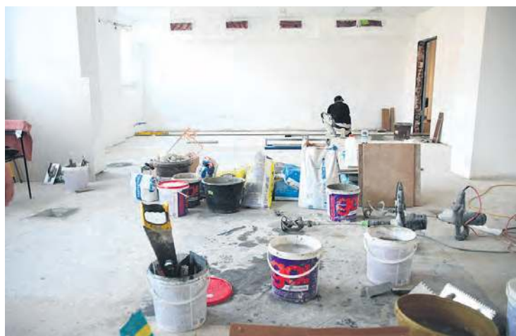
W trakcie budowy jedna z sal dydaktycznych na parterze internatu, który przekształcony został w siedzibę BCU.
