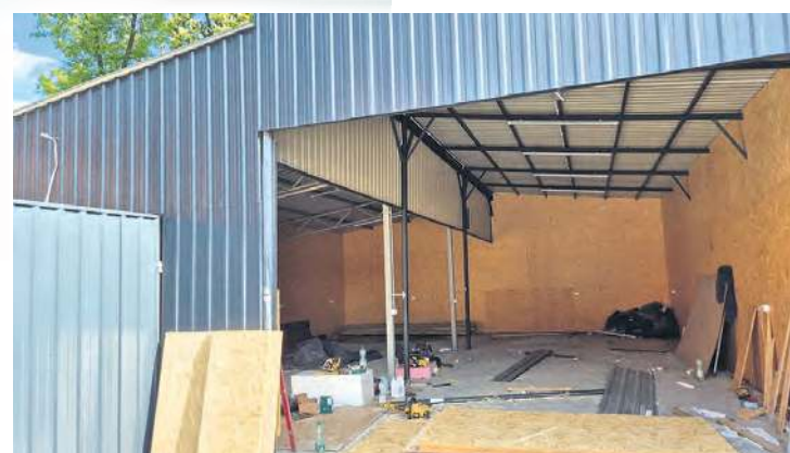
W ramach projektu modernizowane jest pomieszczenie warsztatowe i wiata. Fot. FB Branżowe Centrum Umiejętności – Leśnictwo w Tucholi
