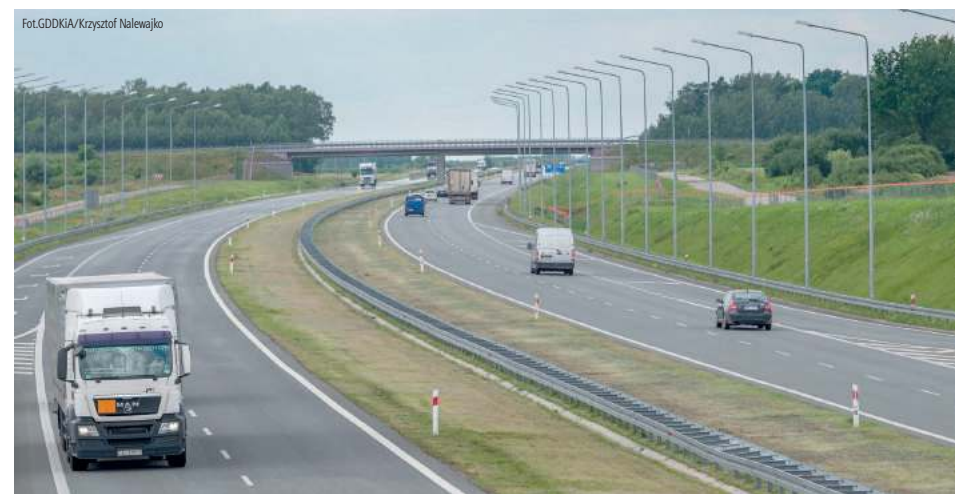
W czerwcu 2012 r. oddano do ruchu odcinek autostrady A2 po zachodniej stronie stolicy. Pięć lat później rozpoczęto budowę przedłużenia A2 - 35 km od Warszawy do funkcjonującej obwodnicy Mińska Mazowieckiego, którą zakończono w sierpniu 2020 r. W realizacji jest dalszy ciąg trasy do Białej Podlaskiej
