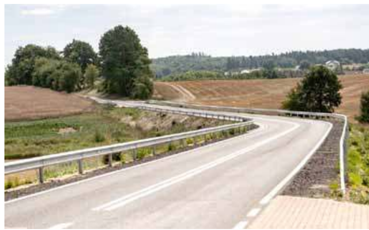
Nowa droga została poszerzona i obecnie ma szerokość 6 metrów
