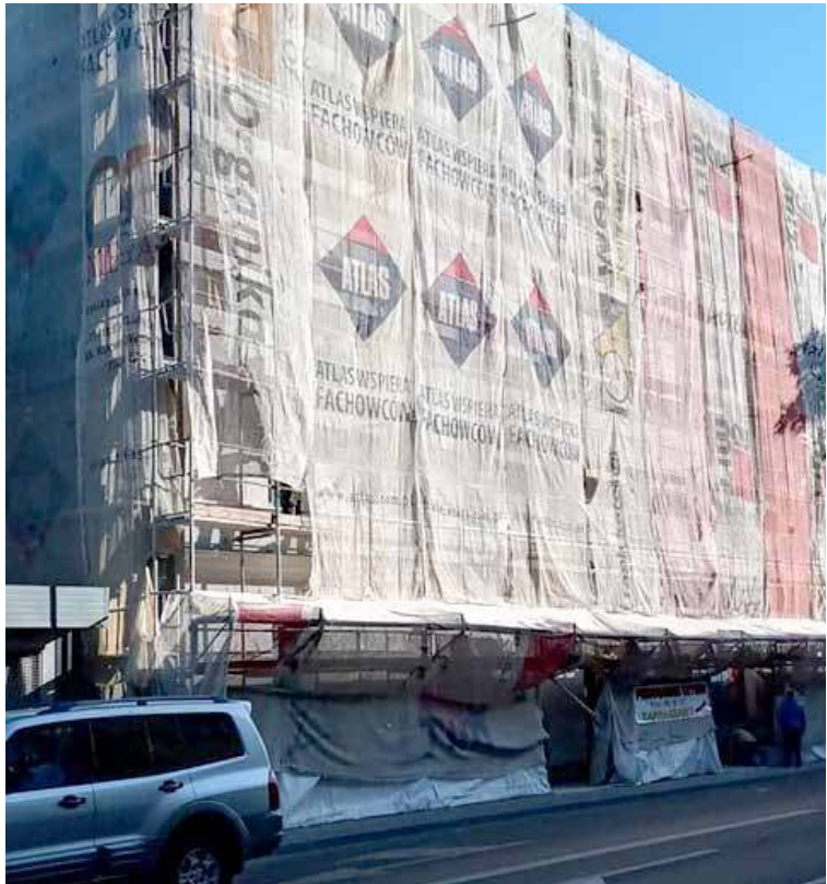
Trwa remont budynku przy ulicy Marii Konopnickiej 8.
