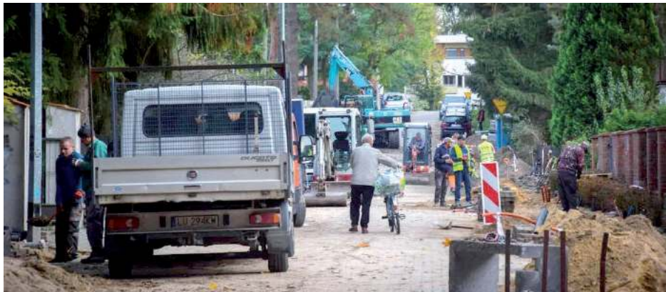
W ul. Kościuszki prace jeszcze trwają, ale powoli zmierzają do końca
