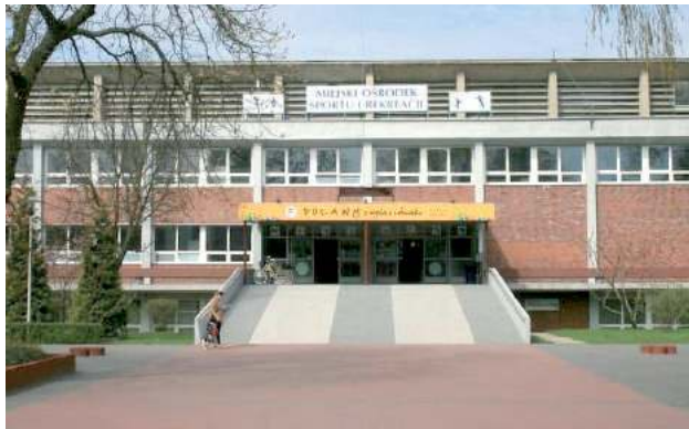
„Stara” hala sportowa służy mieszkańcom Puław od 1974 r. Została wybudowana według projektu znakomitego architekta Wojciecha Zabłockiego
