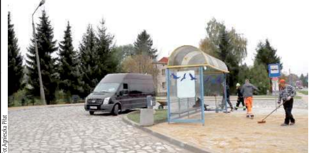
W ostatnich dniach października trwały jeszcze ostatnie szlify, ale już od 18 października autobusy mogły już zajeżdżać w zatoczkę
