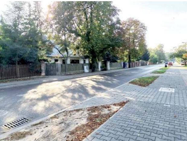
To właśnie tu ma powstać nowe bezpieczne przejście na ul. Skowieszyńskiej. Urzędnicy liczyli, że inwestycję uda się zrealizować jeszcze w tym roku i os. Mokradki. Początkowo urzędnicy odkładali inwestycję na później, głównie z uwagi na kwestie finansowe. W ubiegłym roku
