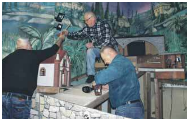
Piotr Płonka i jego ekipa podczas budowy ruchomej szopki w kościele w Orzechu
