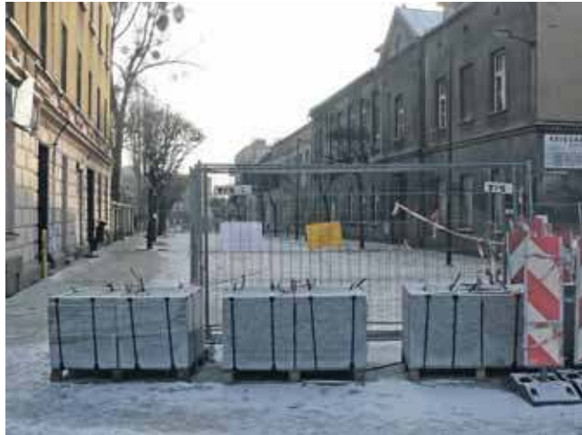
Na koniec remontu ul. Zamkowej trzeba jeszcze poczekać
