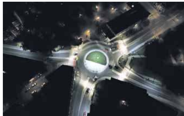
Przebudowa ul. Powstańców Śląskich w Tarnowskich Górach wraz z budową dwóch rond to inwestycja, którą udało się skończyć w 2021 r. Niestety przebudowa ul. Sobieskiego przeciągnie się nawet o pół roku
