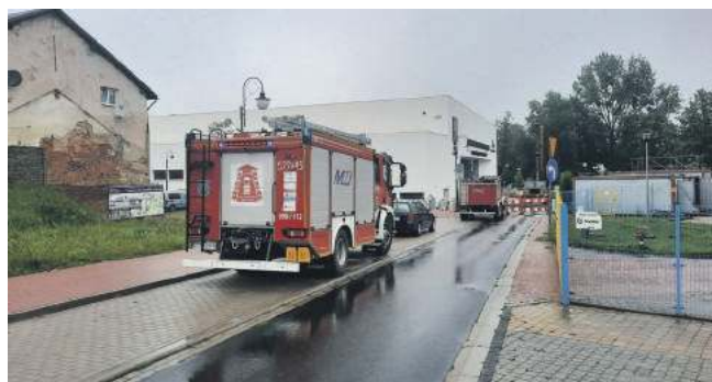
Straż pożarna musiała interweniować w sprawie zalanego placu budowy przy szkole podstawowej
