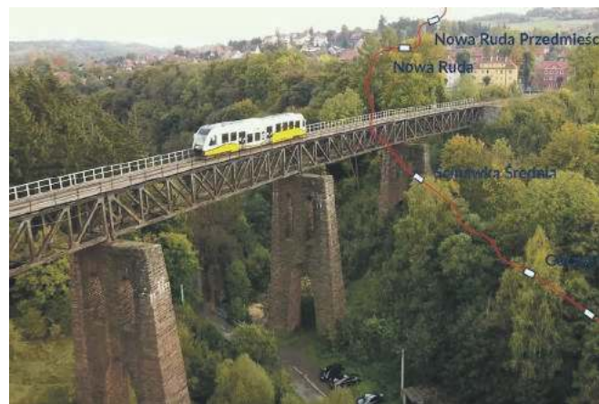
Wiadukt na trasie kolejowej z Wałbrzycha do Kłodzka.
