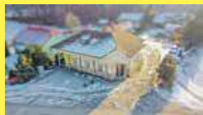
Budynek po dobrze prosperującym sklepie w Miśsiach, pow. 150 m 2 , 669 494 058
